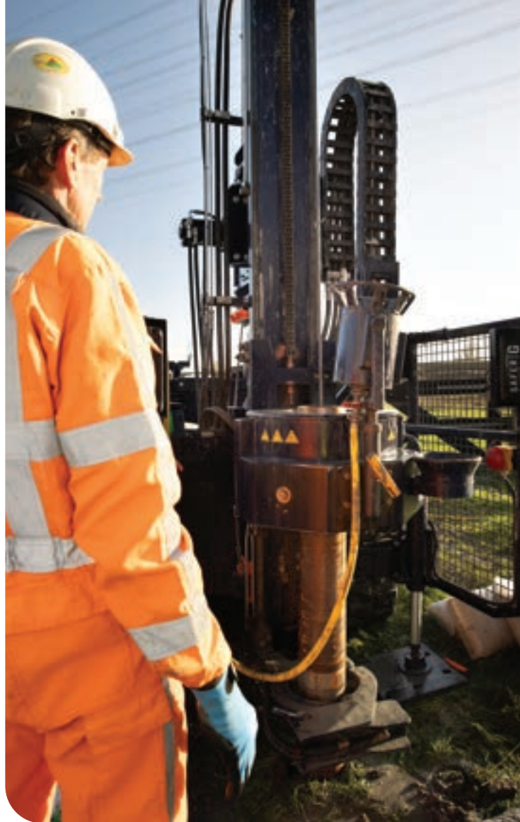
Een boring bij Vlakte om de ondergrond en grondwaterdruk goed in kaart te brengen.
