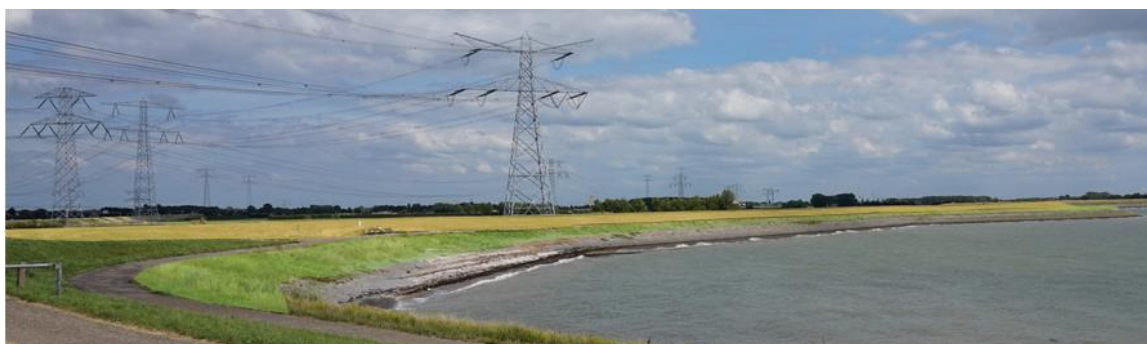
Afbeelding 7.2 Indicatie van de broedbiotoop van bontbekplevier ter hoogte van de Kapellebank (groen). Met gele arcering is het boventalud van de dijk weergegeven waar de bekleding vervangen wordt
