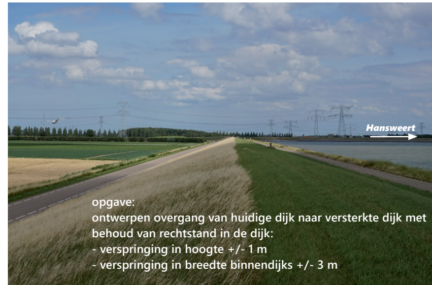
Afbeelding 29 niet versterkte dijk, zicht richting noordoosten
