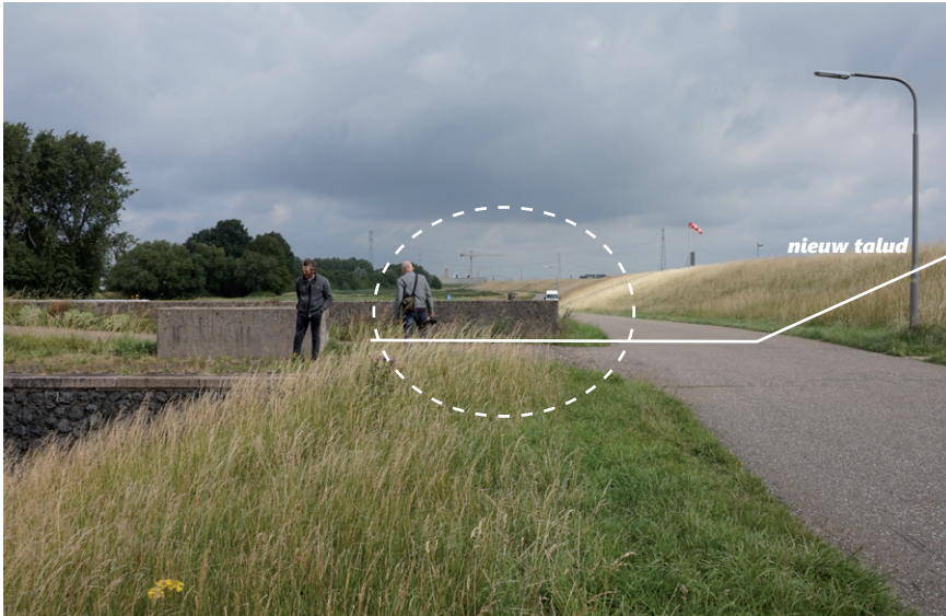
Afbeelding 7 Kanaalijk binnenzijde, raakvlak met muur sluis
