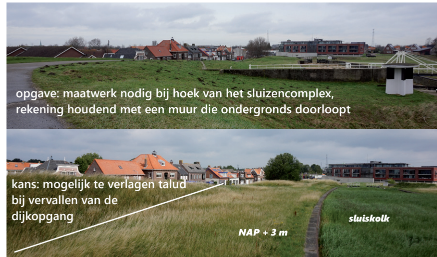
Afbeelding 14 Kleine sluis van oude sluisencomplex
