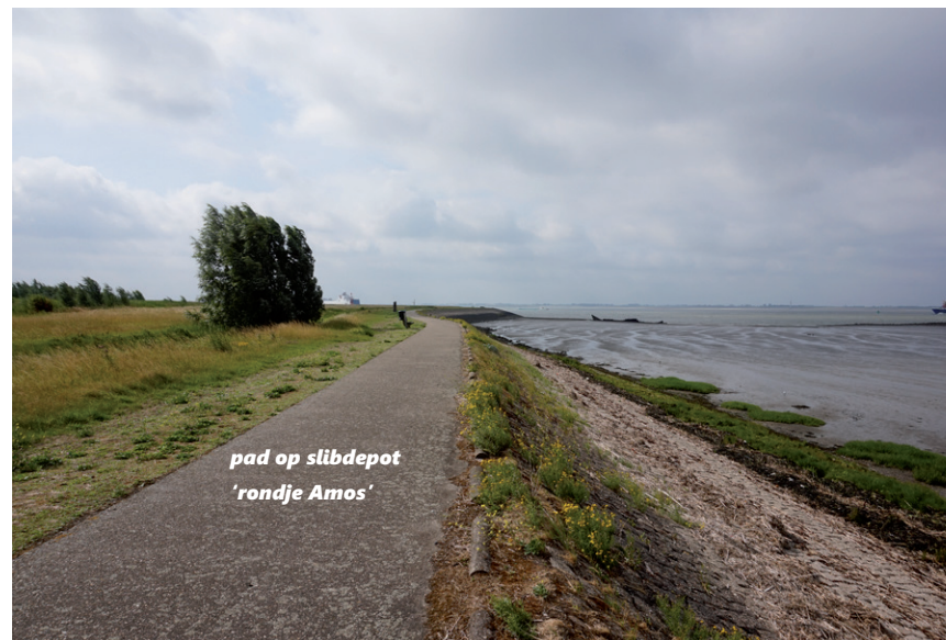
Afbeelding 11 Ringdijk slibdepot. Bekleding buitentalud wordt vervangen (locatie foto buiten kaartbeeld)
