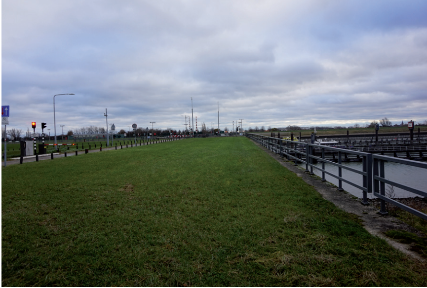
Afbeelding 5 vlak plateau op de sluis waar een hoogte van +1,4 m gerealiseerd moet worden.
