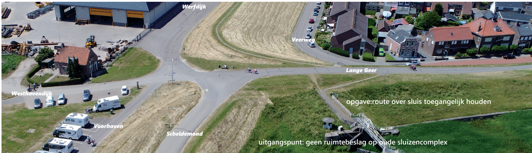
Afbeelding 15 Opgave voor herontwerp wegenstructuur t.h.v. de kruising op dijkkruin die +/- 2,5 m opgehoogd wordt
