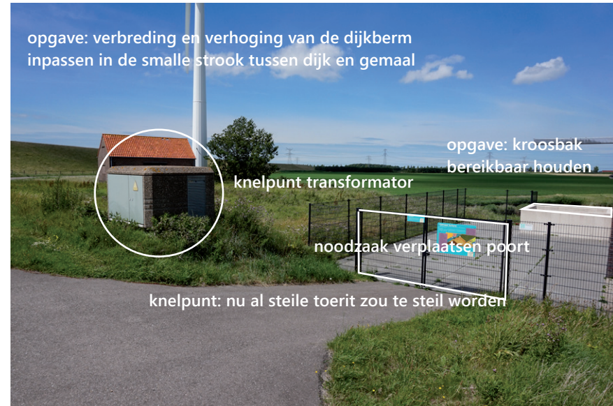
Afbeelding 24 huidige toegang gemaal
