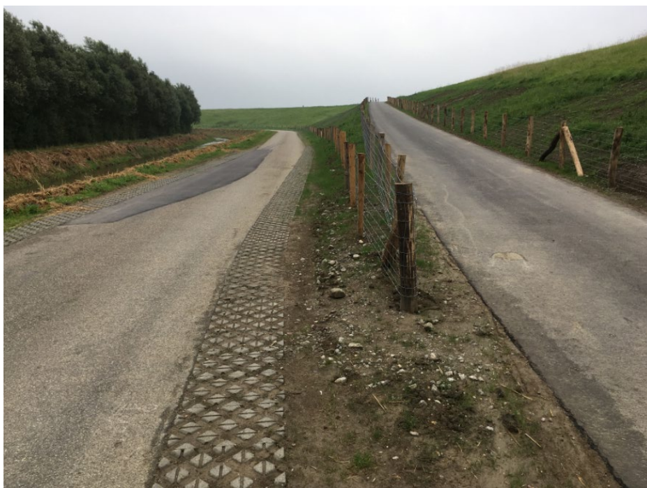
Figuur 3.8: Foto dijkovergang Biezelingse Ham in 's Gravenpolder
