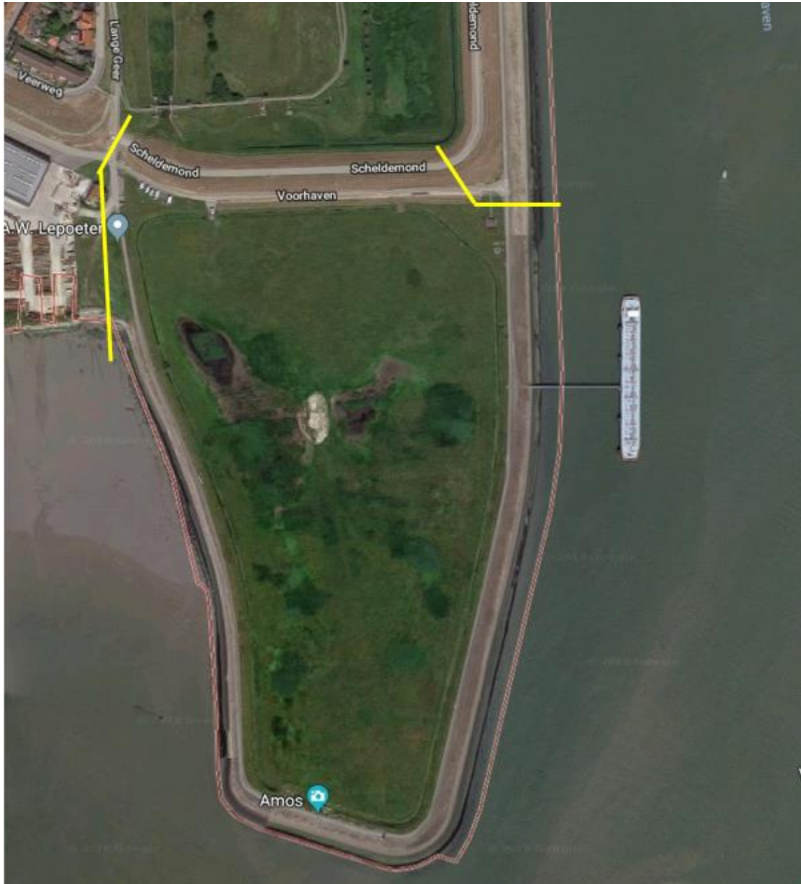
Afbeelding 2.4 Luchtfoto Slibdepot, dijksectie tussen gele markeringen ( www.google.com/maps )
