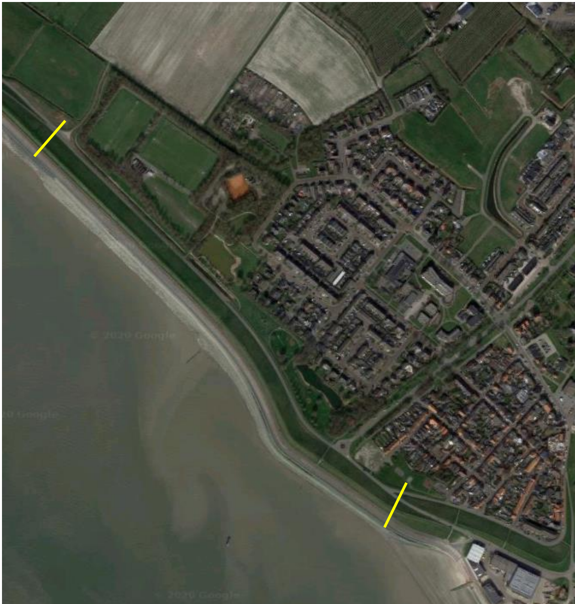
Afbeelding 2.6 Luchtfoto huidige situatie Dorpsrand Zeedijk, dijksectie tussen gele markeringen ( www.google.com/maps )
