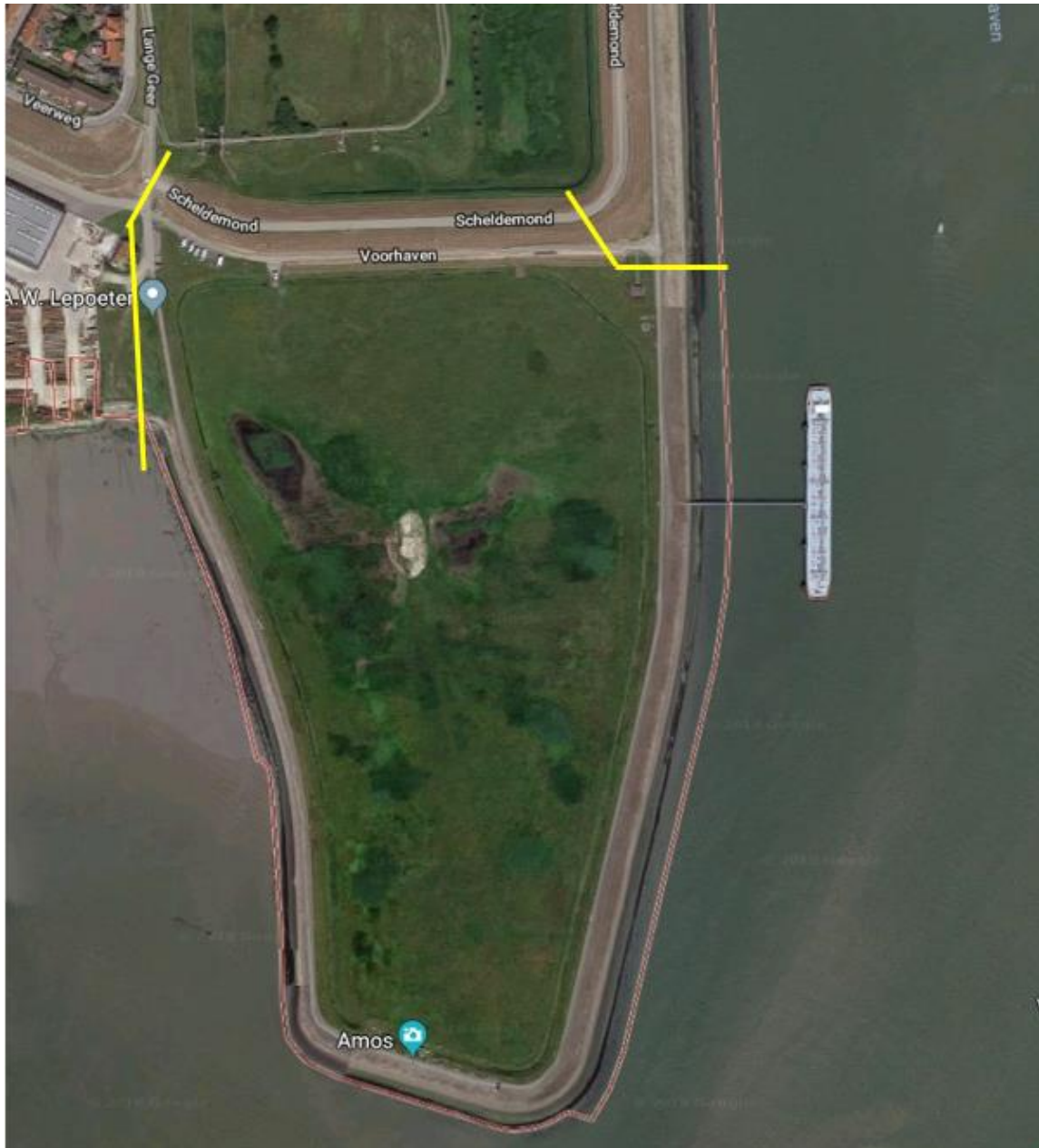
Afbeelding 2.4 Luchtfoto Slibdepot, dijksectie tussen gele markeringen (www.google.com/maps)
