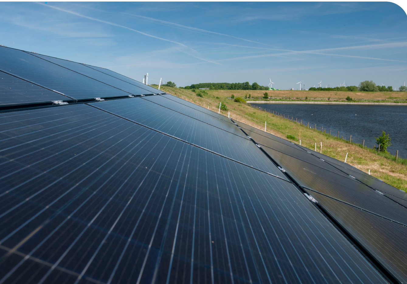
• Figuur 23 - Proeflocatie met • zonnepanelen op de dijk.
