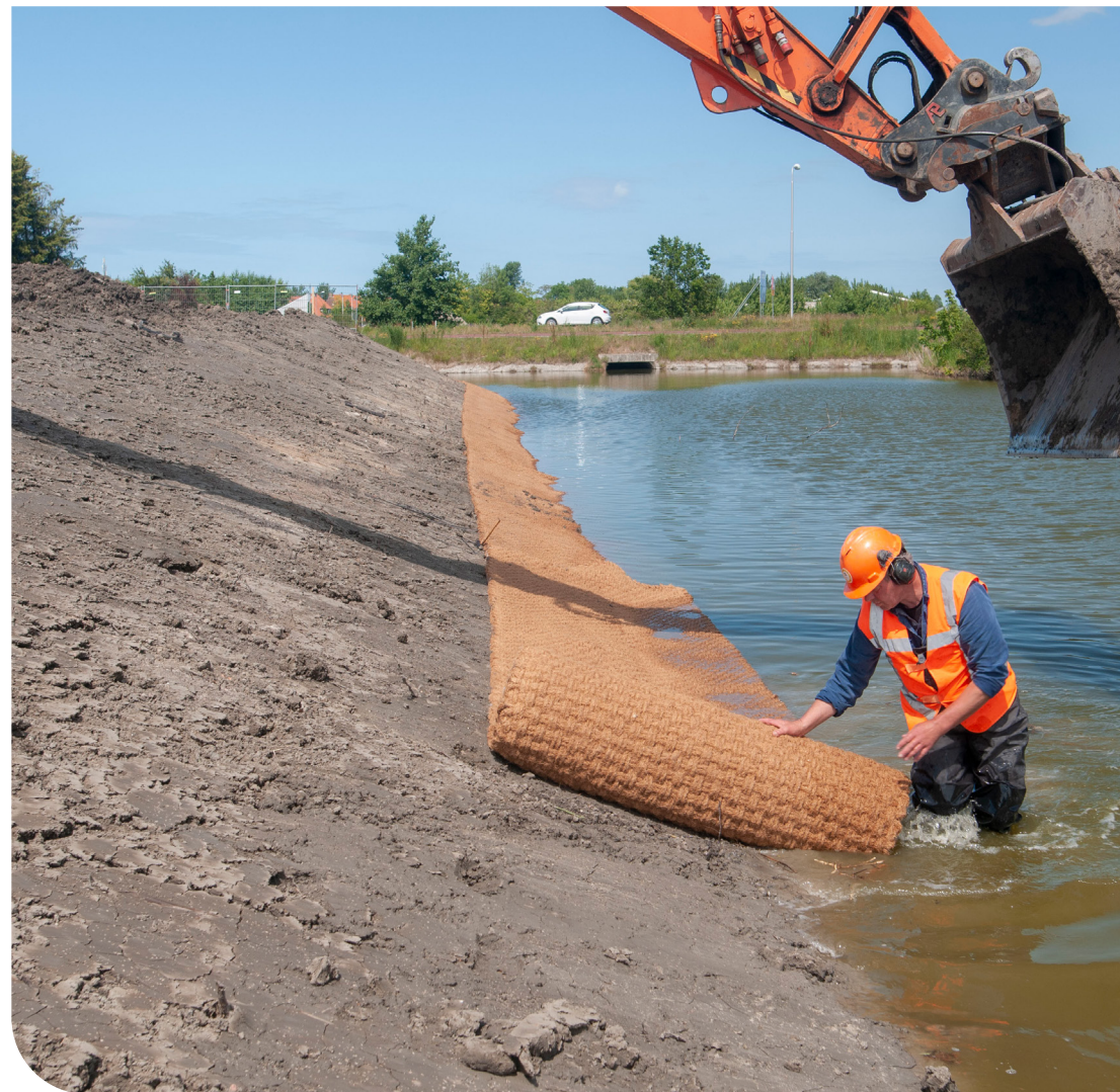
Figuur 24 - Biobased oeverversterking in plaats van kunststof.
